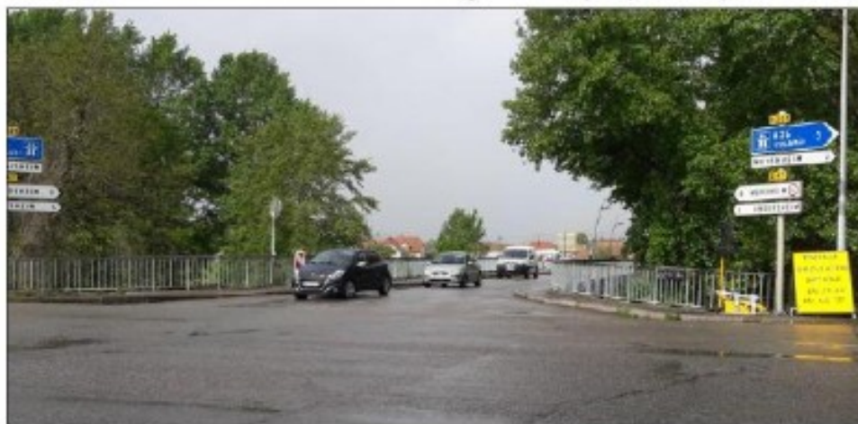
Le pont sur l'Ill, à l'intersection avec la RD201, doit être rénové d'ici le mois d'octobre. Photo DNA
